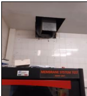
Gaine d'extraction existante à neutraliser et à déposer pour pose de la hotte
